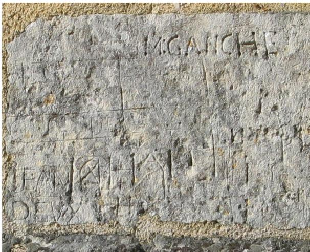
Le tuffeau est pratiquement inexistant dans les contreforts de la façade alors qu'il figure en pourcentage intéressant dans les contreforts gothiques des chapelles. Il se situe principalement dans leur partie supérieure et leur ressaut. Le peu de dureté de ce matériau explique les traces d'un cadran solaire sur un contrefort de la chapelle sud et de nombreux graffiti, pour la plupart des croix. Est aussi mentionné un nom de famille: M. GANCHE.
